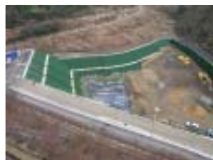
埋立地第11区画のむき出しになった遮水シート
