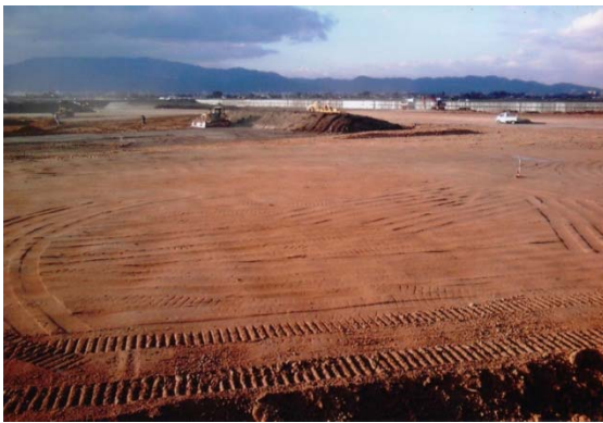
造成工事の現場
